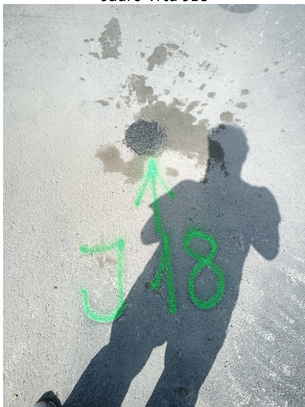
Zapravení Vrtu J18
