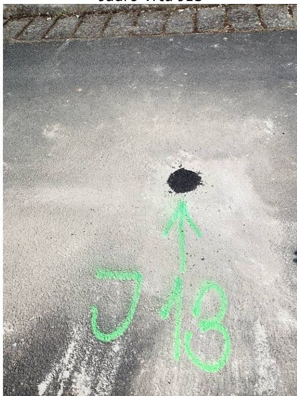
Zapravení Vrtu J13
