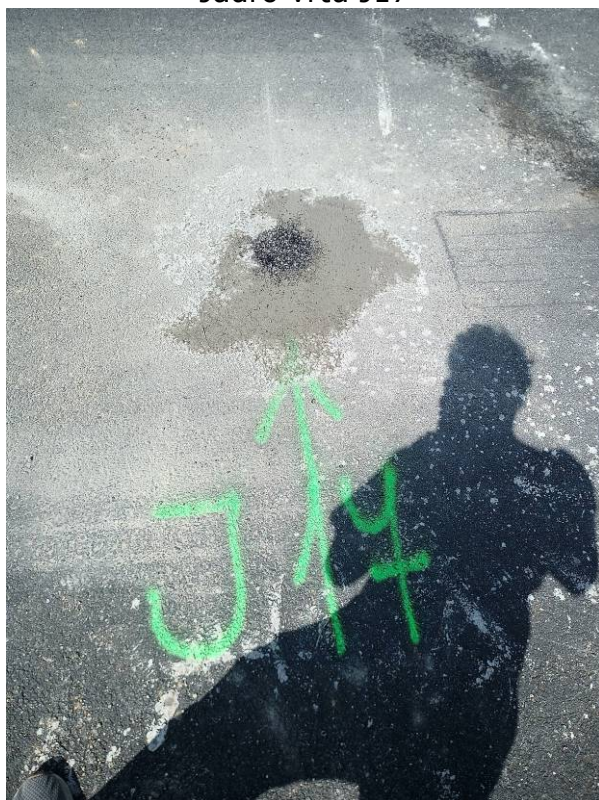
Zapravení vrtu J17
