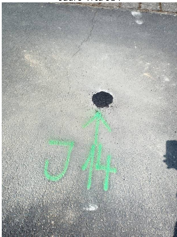
Zapravení vrtu J14
