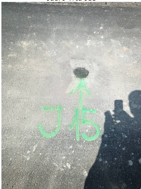
Zapravení vrtu J15
